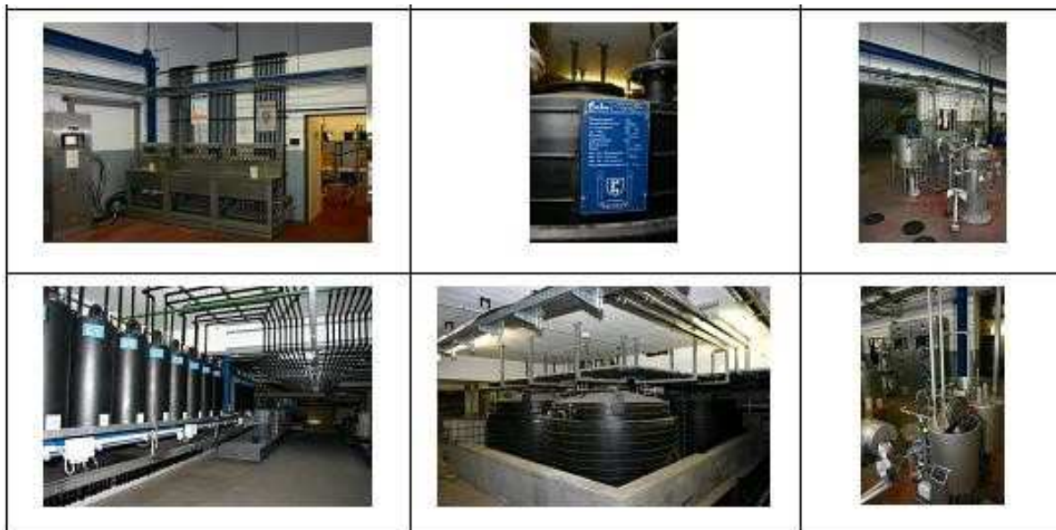
Figura 1: El uso de NaOH en la industria textil actual es en sistema cerrado sin exposición de los trabajadores (izquierda: distribución de NaOH, centro; almacenamiento de NaOH, derecha: uso de NaOH (teñido))
